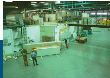
Der Innenausbau der noch fast leeren Experimentierhalle nimmt schnell Fahrt auf. Neue Ideen für Experimente entstehen.
